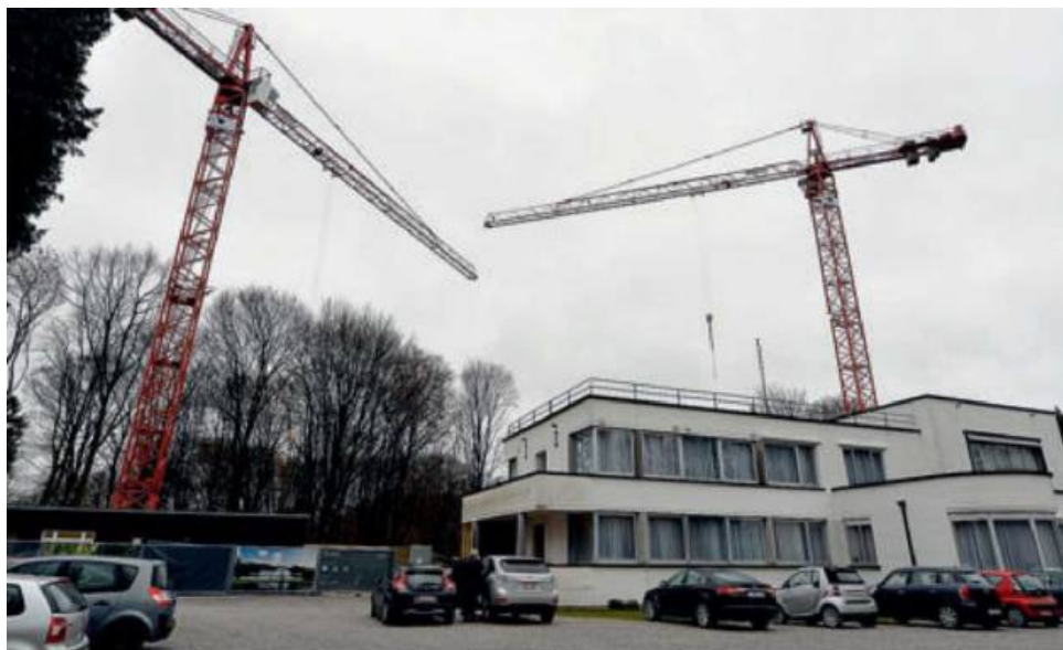
Travaux en cours à Waterloo pour le "New Building" de la Chapelle musicale Reine Elisabeth.
